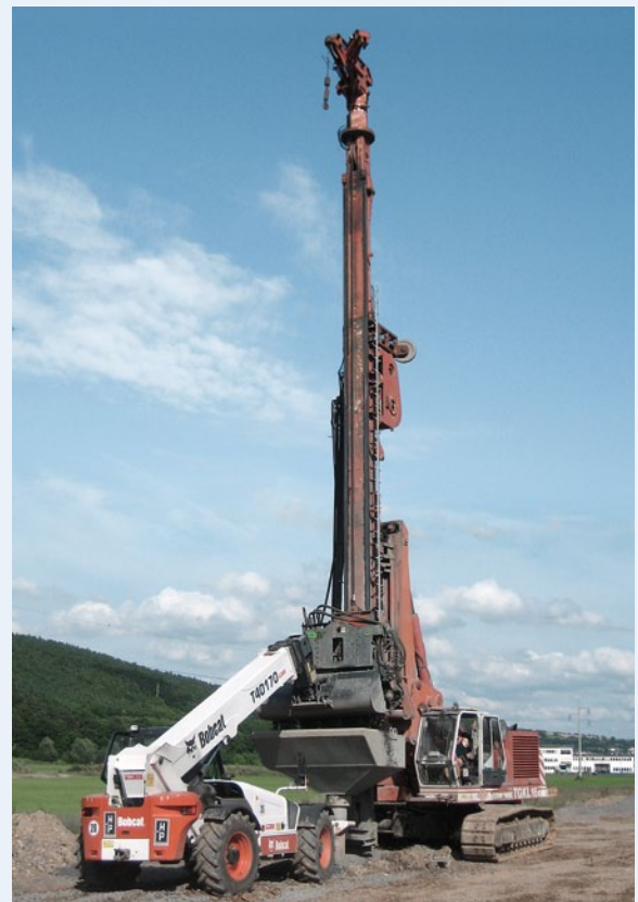
Befüllung des Stottertrichters, Bauvorhaben Philippsthal
