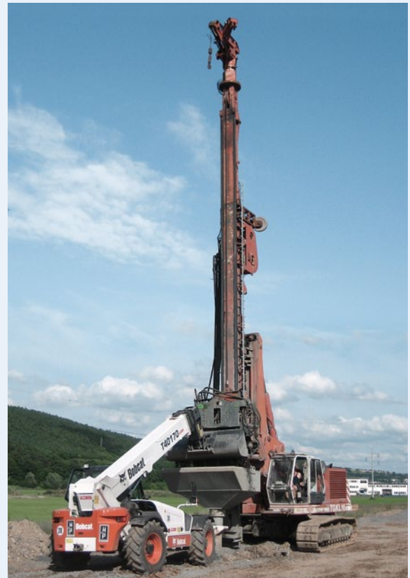
Befüllung des Stottertrichters, Bauvorhaben Philippsthal
