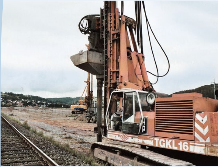
Erschütterungsarme Säulenherstellung unmittelbar neben einer Bahnlinie
