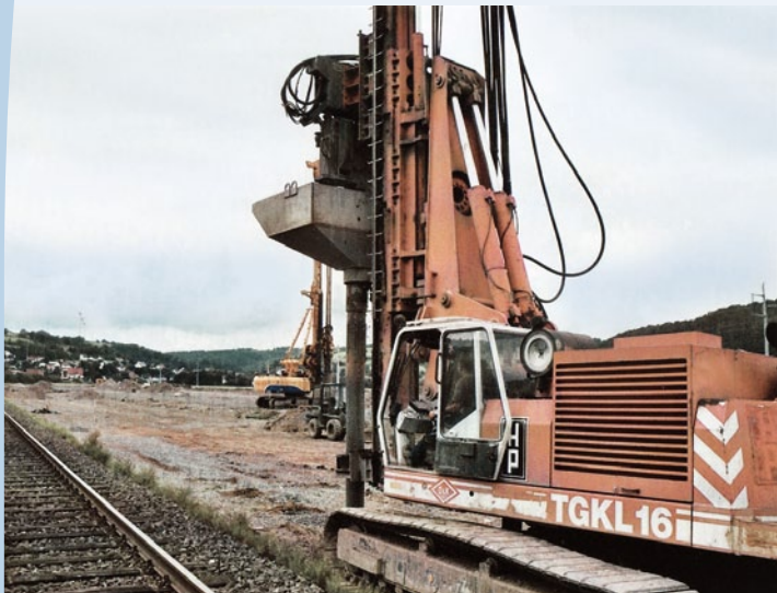
Erschütterungsarme Säulenherstellung unmittelbar neben einer Bahnlinie
