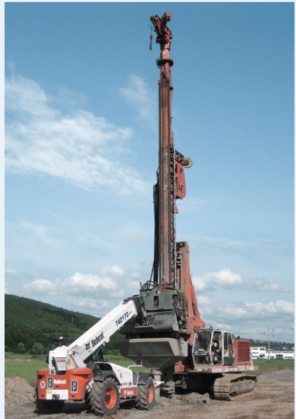
Befüllung des Schottertrichters, Bauvorhaben Philippsthal
