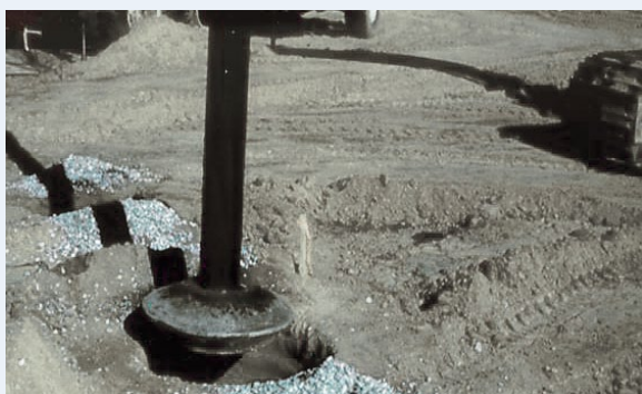
Запатентованная трамбовка специальной формы Geopier®
