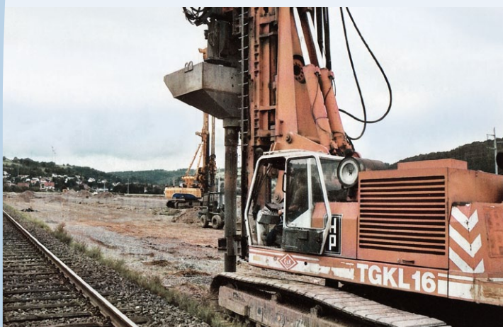
Маловибрационное изготовление свай в непосредственной близости от ж/д пути
